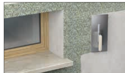
Buntstein-Sockelputz auftragen. (Abb. Caparol)
