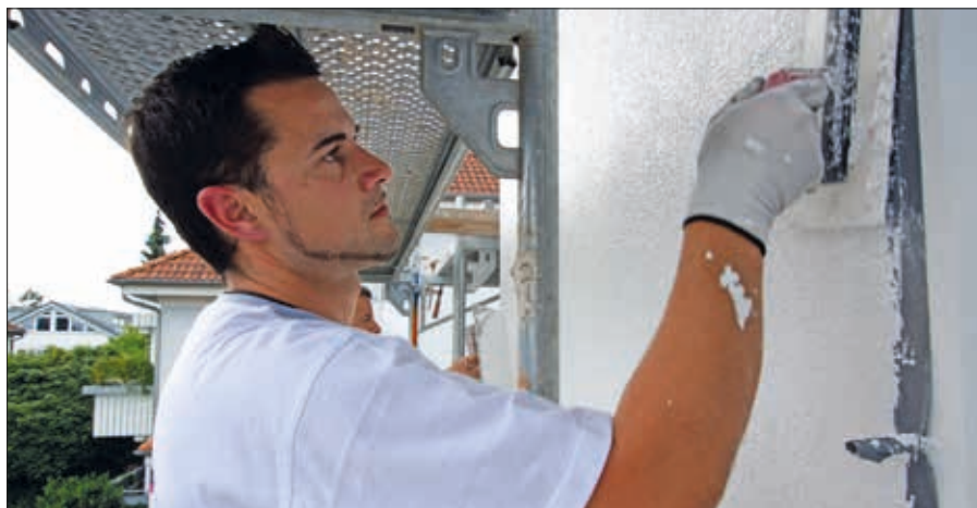
Gleichmäßiges Verteilen und Strukturieren des Oberputzes auf einer Fassade. (Fotos: Caparol)
