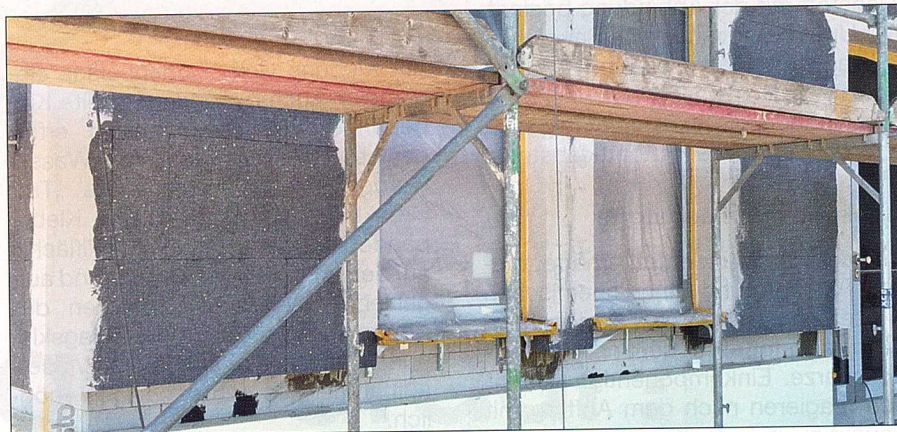
Verarbeitung eines Wärmedämmverbundsystems am Neubau eines Therapiezentrums.
