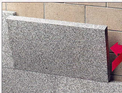
Verlegen von Dämmplatten mit senkrecht versetzten Stoßfugen.
